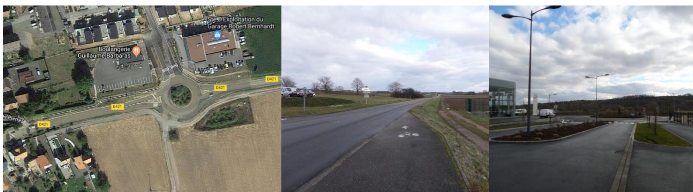
Giratoire entrée Est – Source : Google Maps RD421 vers Mommenheim – Source : OTE Ingénierie 2019 Rue des moissons – Source OTE Ingénierie 2019
