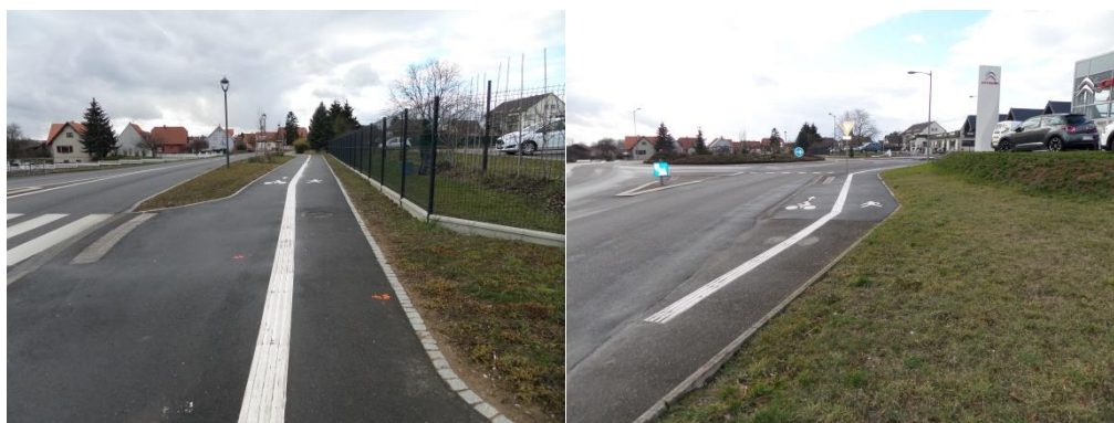
Piste cyclable et voie piétonne, nord RD421 – Source : OTE Ingénierie 2019
