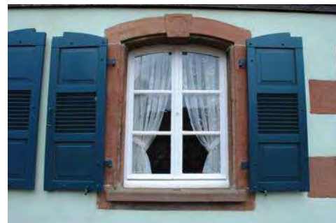
Alteckendorf, 6 carreaux et petits bois, volets à persiennes au 2/3
