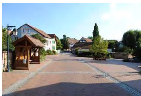
Hohfrankenheim – pavés béton, caniveau en granit
