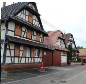
Alteckendorf, toiture à deux pans, pignon sur rue avec demi-croupe
