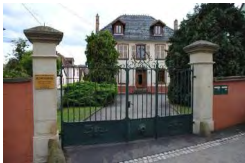
Hochfelden, maison de maître
