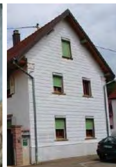
Ettendorf - enduit ciment, peinture plastique, bardage en fibrociment ou plastique.
