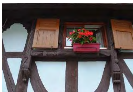
Ettendorf, encadrement à chambranle saillant mouluré
