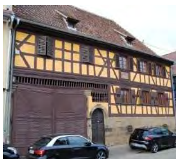
Duntzenheim, toiture à deux pans, gouttereau sur rue
