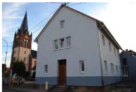
Ingenheim, isolation par l'extérieur d'un bâtiment en pierre
