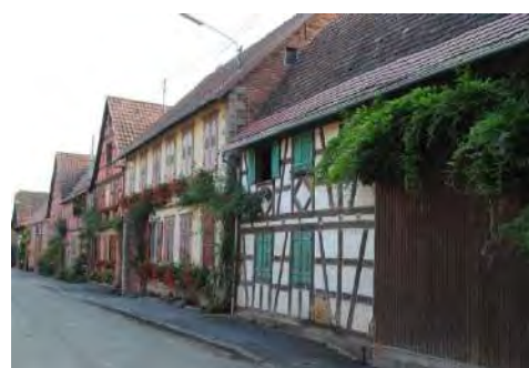
Issenhausen – végétation en façade
