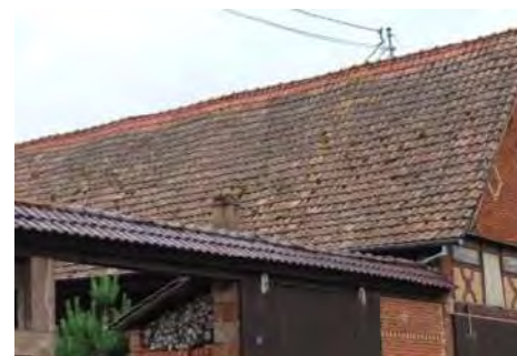
Alteckendorf, tuiles mécaniques en terre cuite
