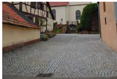
Grassendorf – pavés récents en granit, avec caniveau central et pose en queue de paon
