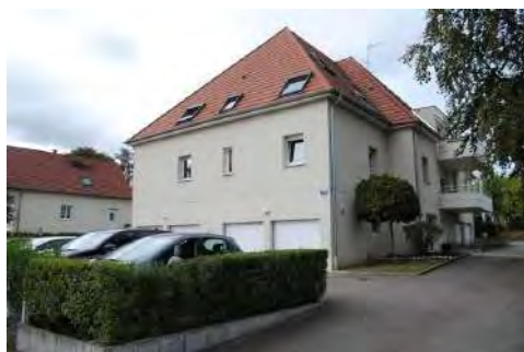
Hochfelden : bâti implanté avec un faible recul par rapport à l'espace public, plantations sur le parvis de l'immeuble, pas de clôtures. Stationnement de voitures situé à côté de l'immeuble et séparé de la rue par une haie. Les liens à l'espace public sont mis en valeur.
