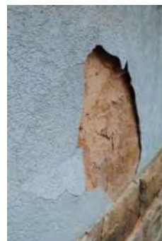
Ettendorf - enduit ciment, peinture plastique, bardage en fibrociment ou plastique.
