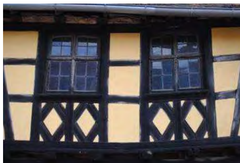
Issenhausen, croisée avec petits carreaux joint au plomb
