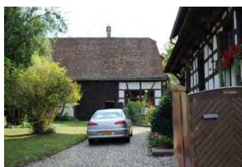
Bossendorf, aménagement d'une ancienne dépendance en conservant son caractère architectural.
