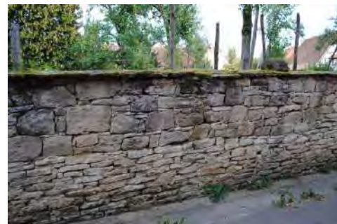
Duntzenheim – mur de soutènement
