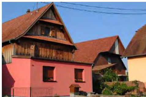
Lixhausen, transformation inadaptée du bâti ancien - adjonction sur la façade avant.
