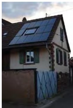
Ingenheim – panneaux solaires
