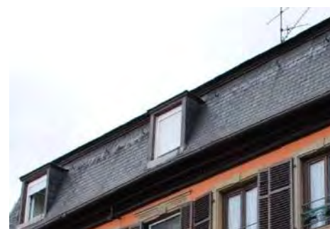
Hochfelden, couverture en ardoise
