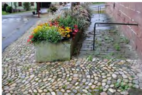
Waltenheim-sur-Zorn - pavés anciens en pierre naturelle – pose en queue de paon
