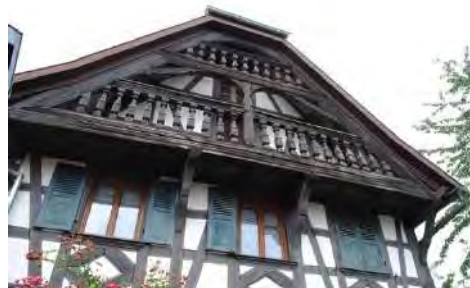
Alteckendorf, maison Schini, galerie de bois sur le mur pignon
