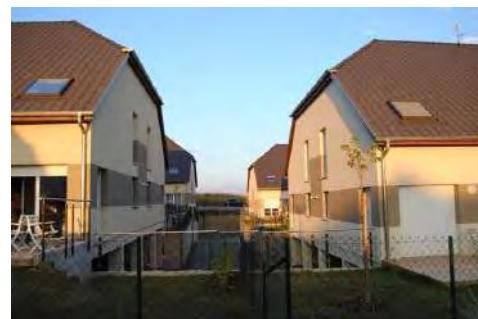
Schwindratzheim : maisons intermédiaires organisées autour d'une cour privée centrale, espace clos. Présence des espaces extérieurs privatifs. Pas de liens à l'espace public environnant.
