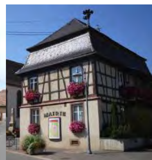
Wickersheim, toiture à la Mansart
