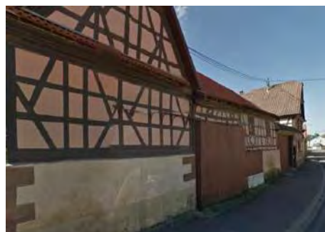
Duntzenheim – avant la démolition (image street-view google maps)
