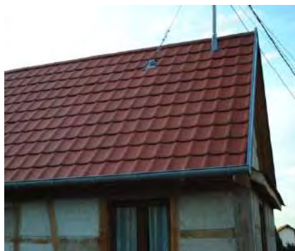
Ingenheim – tuiles mécaniques
