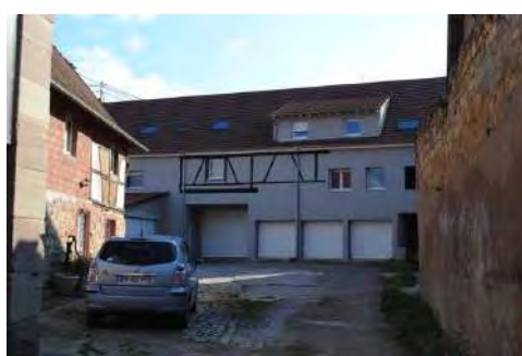
Bossendorf, transformation de dépendance en logements, sans conservation du caractère architectural.
